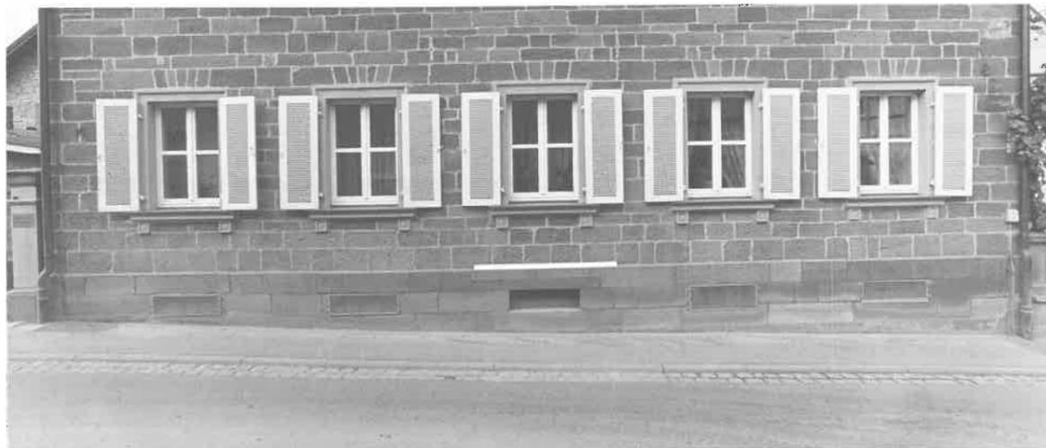
Sockelbereich mit Lüftungsöffnungen
