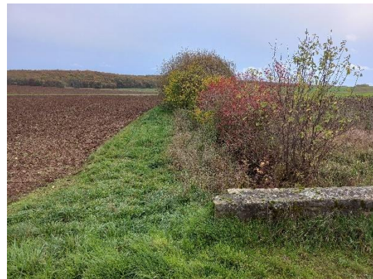
Abb. 35: Grabenbereich mit steilen Böschungen westlich des Flurstückes 760 (04.11.2022)
