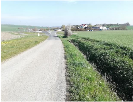
Abb. 6: Strukturarmer Entwässerungsgraben entlang des Asphaltweges, Blickrichtung Norden
